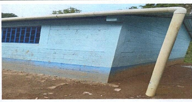
Foto 6: mejoramiento de canal de bajada de agua pluvial
