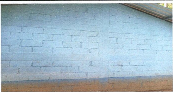
Foto 5: mejoramiento de modulos con pintura exterior
