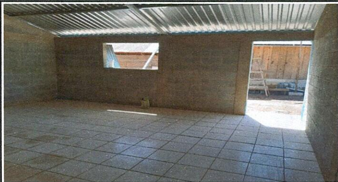
Foto1: mejoramiento e instalacion de piso ceramico
