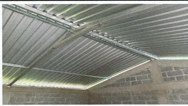
Foto 2: mejoramiento de estructura metalica y techo troquelado
