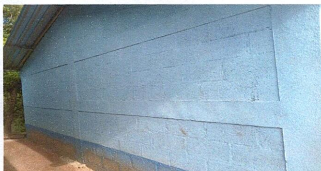
Foto 3: mejoramiento de pared de los modulos
